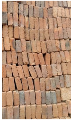
Gambar 5. Batu bata sudah jadi
