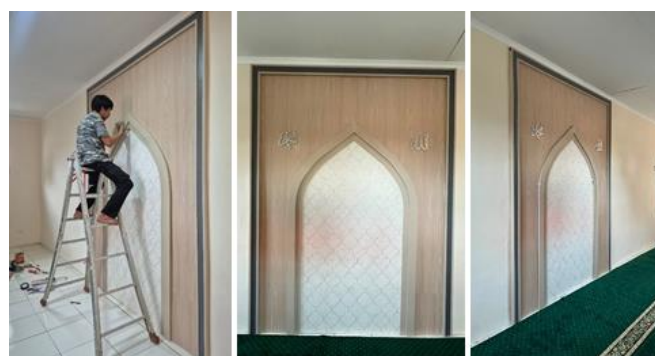
Gambar 6. Pemasangan Panel Mihrab
